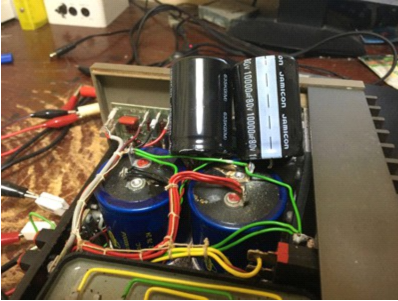
交換後、確認作業
