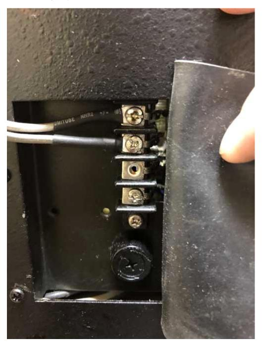
配線保護、感電やショート防止のため保護カバーを作成し組付ける
